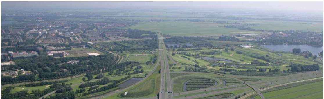
Westelijke tunnelmond nabij Amsterdam Zuidoost en Abcoude, met tunnel die ten oosten van spoor onder de grond is (vogelperspectief en fotovisualisatie)
