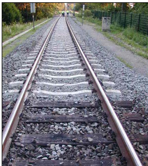
Afb.7: Overgang houten dwarsliggers naar beton (oude naar nieuwe ballast).
