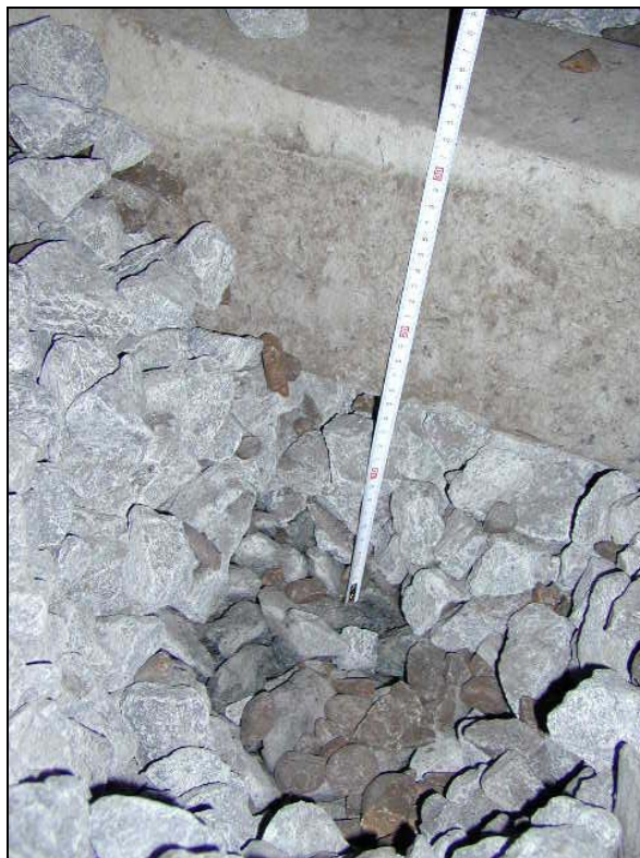
Afb.12: Oude ballast bevindt zich op ca. 15 cm onder onderzijde dwarsligger, gemeten in het hart van het spoor. In de oude ballast is veel rond grind zichtbaar.
