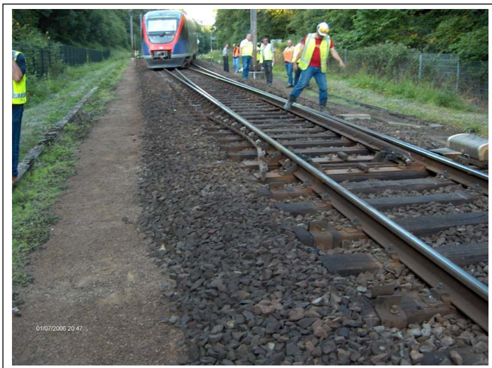
Afb.5: De Talent staat op wissel 111 te Landgraaf. Het wissel leidt de trein naar rechts, het ontspoorde draaistel raakt de wisseltong aan de verkeerde zijde en wordt naar links geleid.
