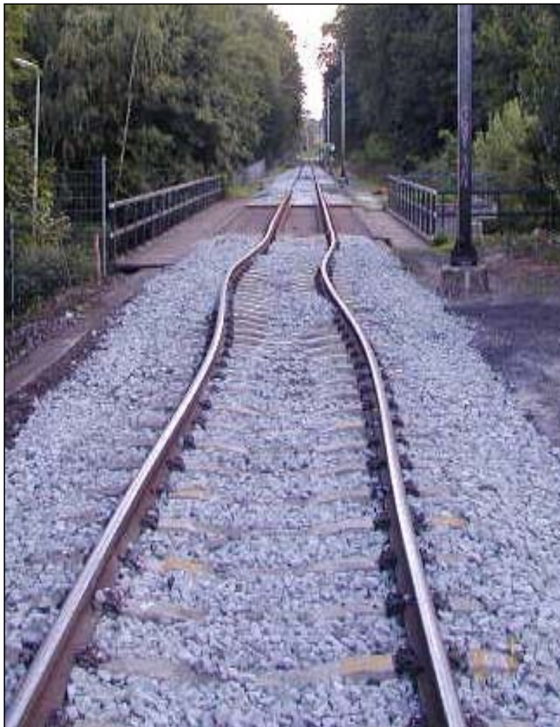
Afb. 11: Toestand van het spoor op de plaats waar ontsparing plaats heeft gevonden
