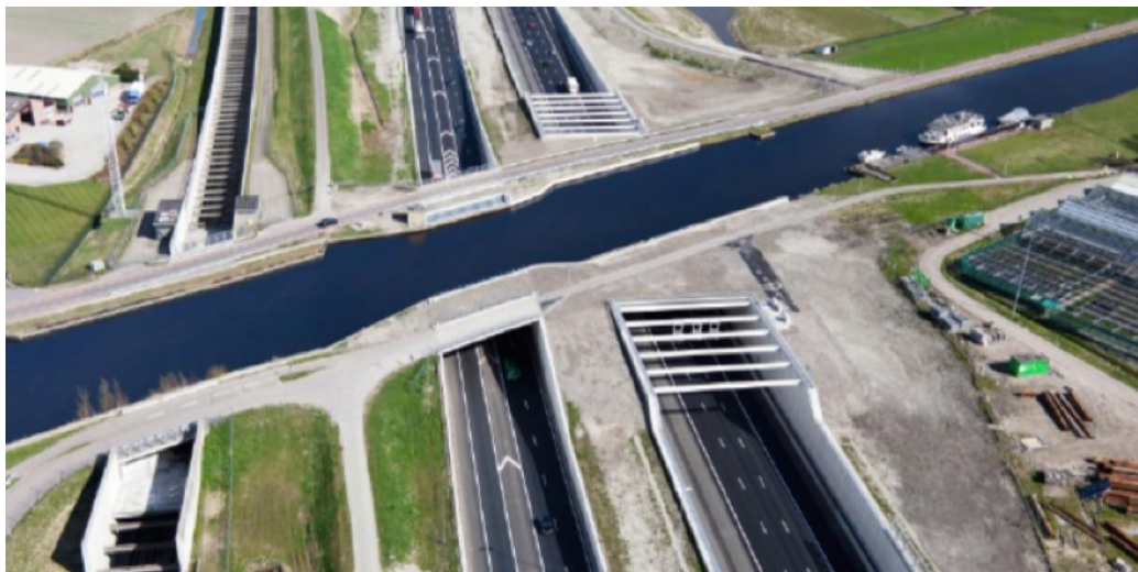
Figuur 3.3: Huidige ligging Ringvaartaquaduct met links de ligging van het oude aquaduct en rechts de ligging van het nieuwe aquaduct uit 2010
