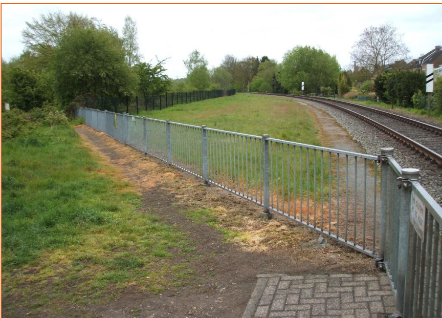
Afbeelding 2, overweg Landweg/Wormvoetpad, zicht naar het zuiden.
