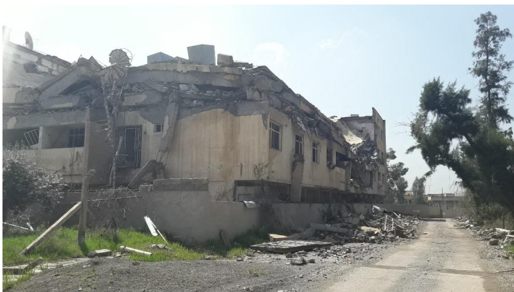
Foto 4: Noordwestzijde gebouw, muur langs gebouw deels zichtbaar. 5.1.2.e
