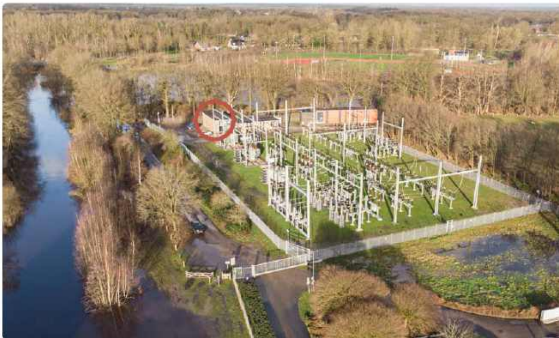
Figuur 6: Het stroomverdeelstation Nijverdal op 26 december 2023 gefotografeerd vanuit zuidelijke richting. Links de oude gekanaliseerde loop van de Regge. Rondom zijn plassen zichtbaar. De nieuwe meanderende loop bevindt zich achter het stroomverdeelstation. In het linker gebouw (in de rode cirkel) ontstond de kortsluiting (bron: Bert Kamp, News United).
