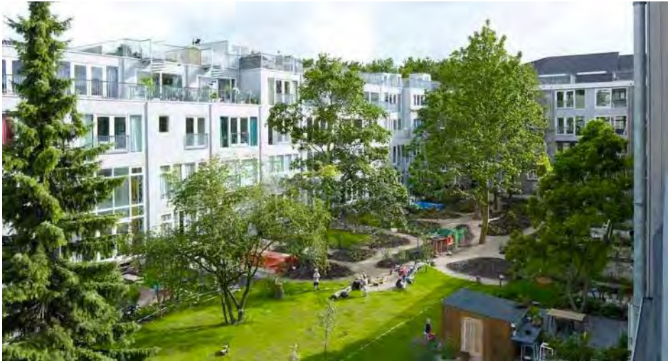
Bouwblokken van gemiddelde dichtheid met een mix van type woningen en gemeenschappelijke groene binnentuinen. Wallisblok, Rotterdam
