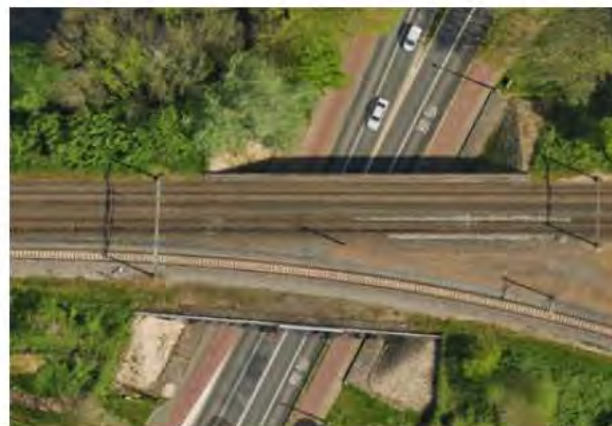
Figuur 4.3: dwangpunt spoorviaduct IJssellaan (rechts is richting Zevenaar)
