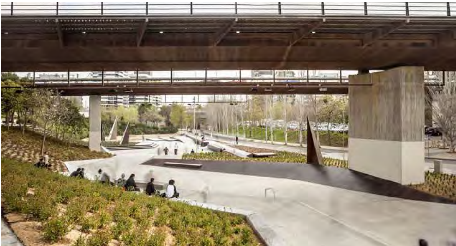
Prettige verblijfsruimte onder een (spoor)viaduct. Les Corts Landskate Park Barcelona
