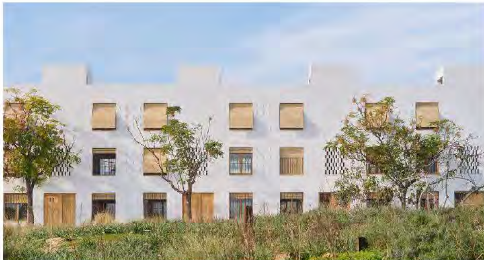
Appartementengebouwen dienen als Friendly Neighbour door geringe omvang van 3-4 bouwlagen. Palma, Spanje
