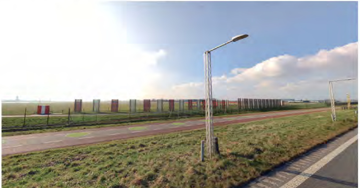
Figuur 2-1 Huidige schermen langs het Larserpad ten behoeve van jet blast (bron: cyclomedia.nl)
