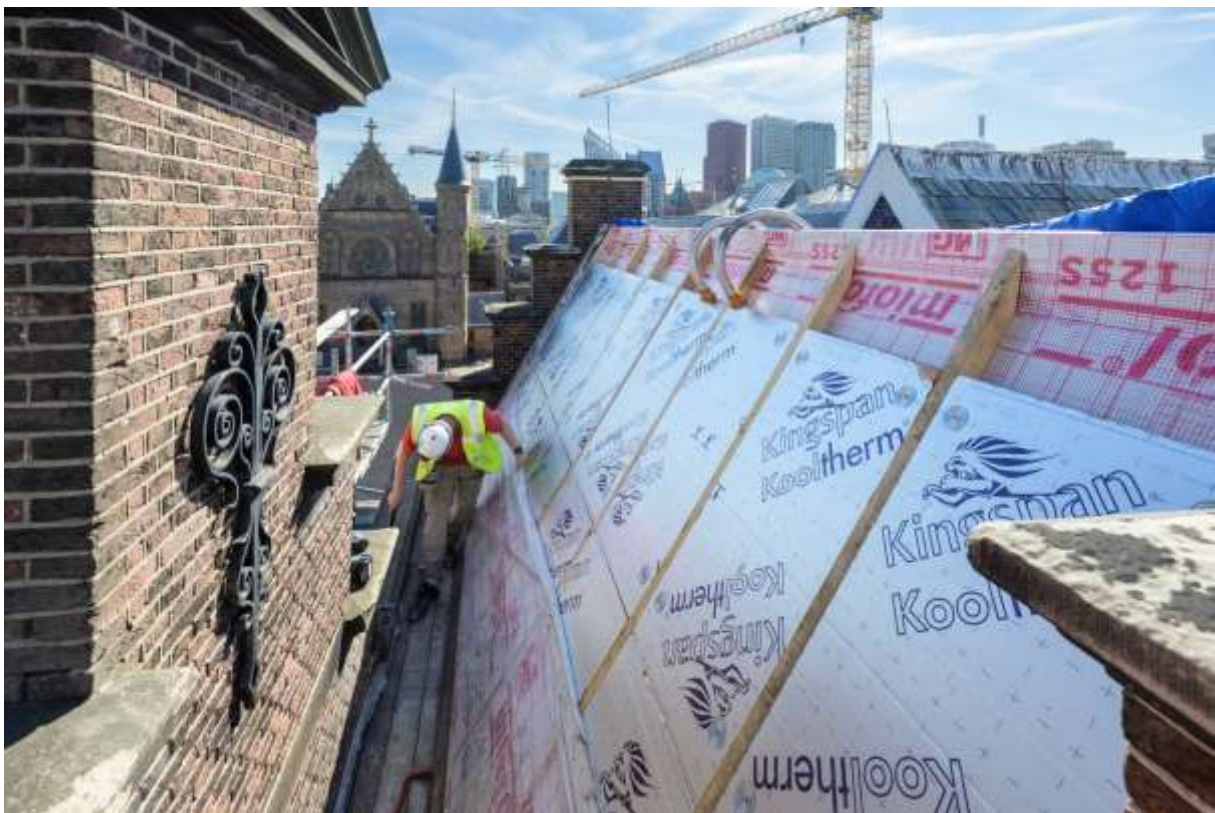
(Afbeelding 6: Renovatiewerkzaamheden Raad van State)
