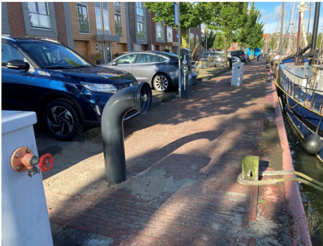
Periscoop pijp Harlingen met Camock 50 aansluiting
