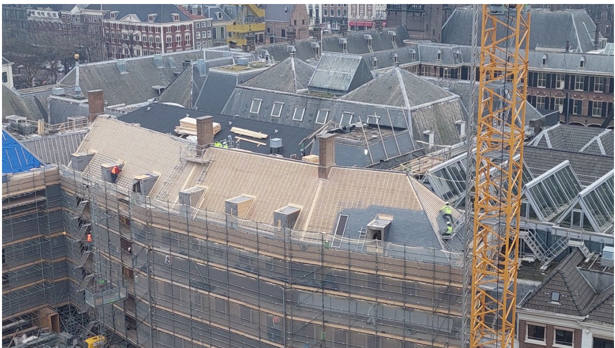
Werkzaamheden daken Tweede Kamer
