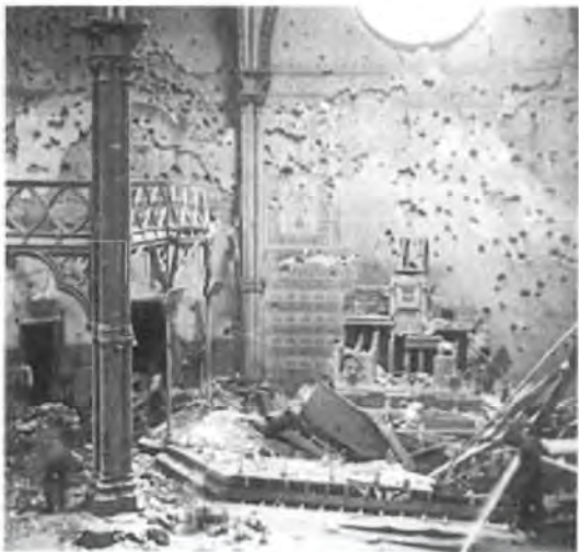
De vuurbal kan brandwonden en secundaire branden veroorzaken tot op gegeven afstanden.
