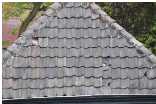
Vergunning voor vervangen dakpannen?
