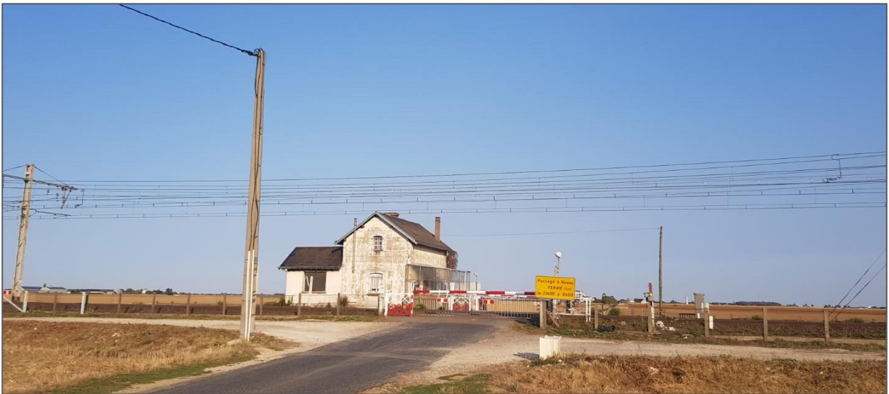
Figuur 1: Een van de laatste bewaakte en handbediende overwegen in Frankrijk in de met 200 kilometer per uur bereden, driesporige, spoorlijn Parijs – Orleans. Eigen foto uit september 2020.
