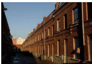
Te renoveren woningen in Quartier Ouest , Roubaix
