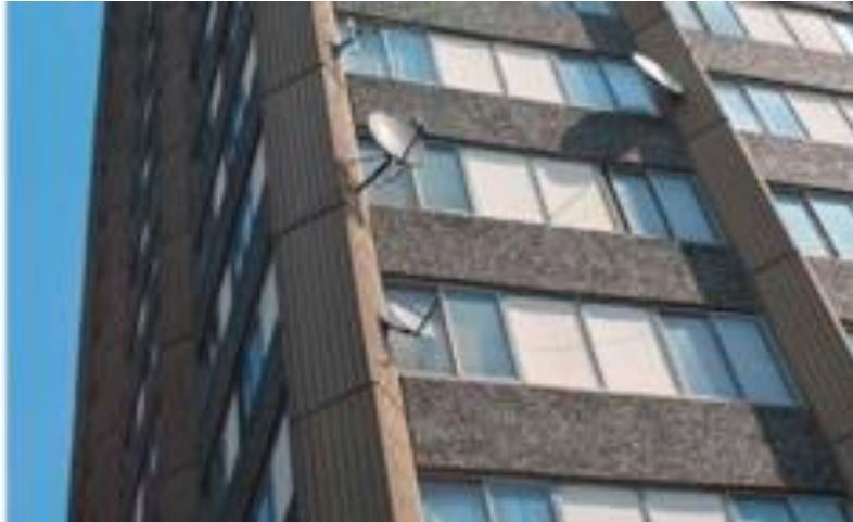
Figuur 4 Oorspronkelijke betongevel van Grenfell Tower voor de renovatie (Bron: deel van figuur 3.2 uit het GTI Phase 1 Report in § 3.10)
