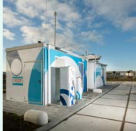
Waterstof-tankstation voor openbaar vervoer, Delfzijl.
