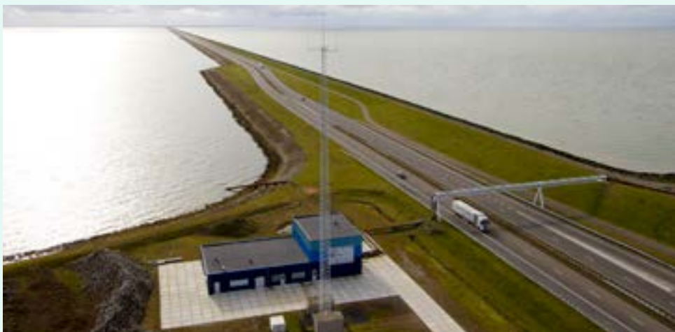
Thermische energie uit oppervlaktewater: Blue Energy op de Afsluitdijk. In deze proefinstallatie wordt energie gewonnen uit het verschil in zoutconcentratie van zout- en zoetwater.
