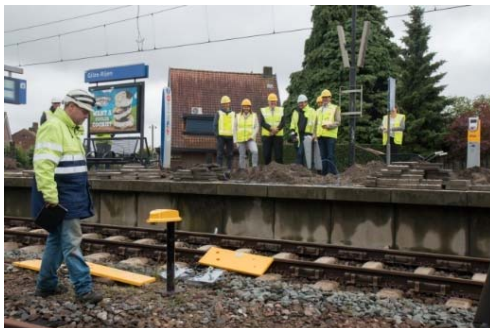
aanleg ATB-Vv bij Gilze-Rijen
