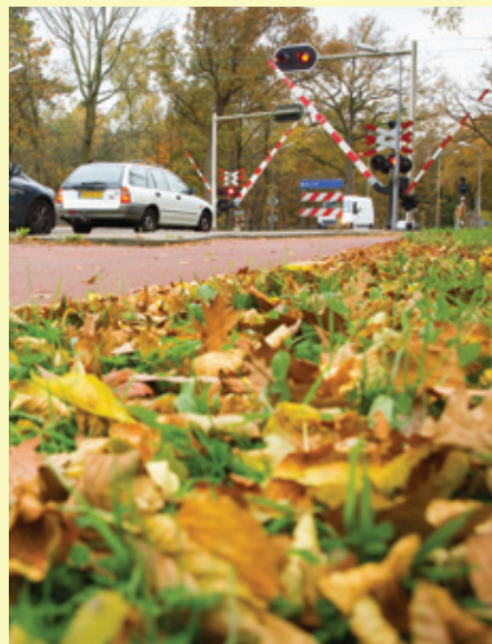
Actieve beveiliging door middel van AHOB, het meest gangbare systeem in Nederland.
