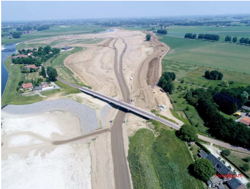
Hoogwaterbrug, rivierverruiming en kadewerkzaamheden bij Visserweert
