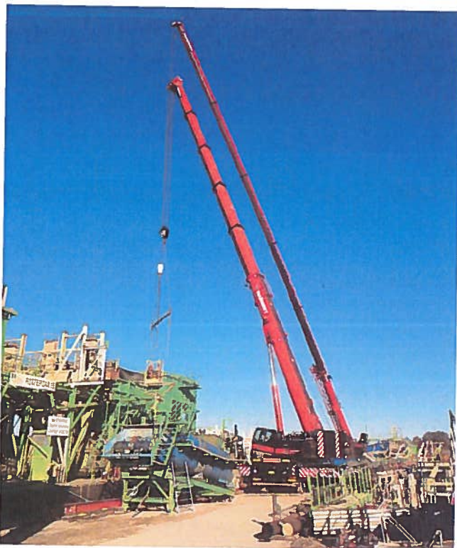
Demontage van "de Rotterdam" te Itteren
