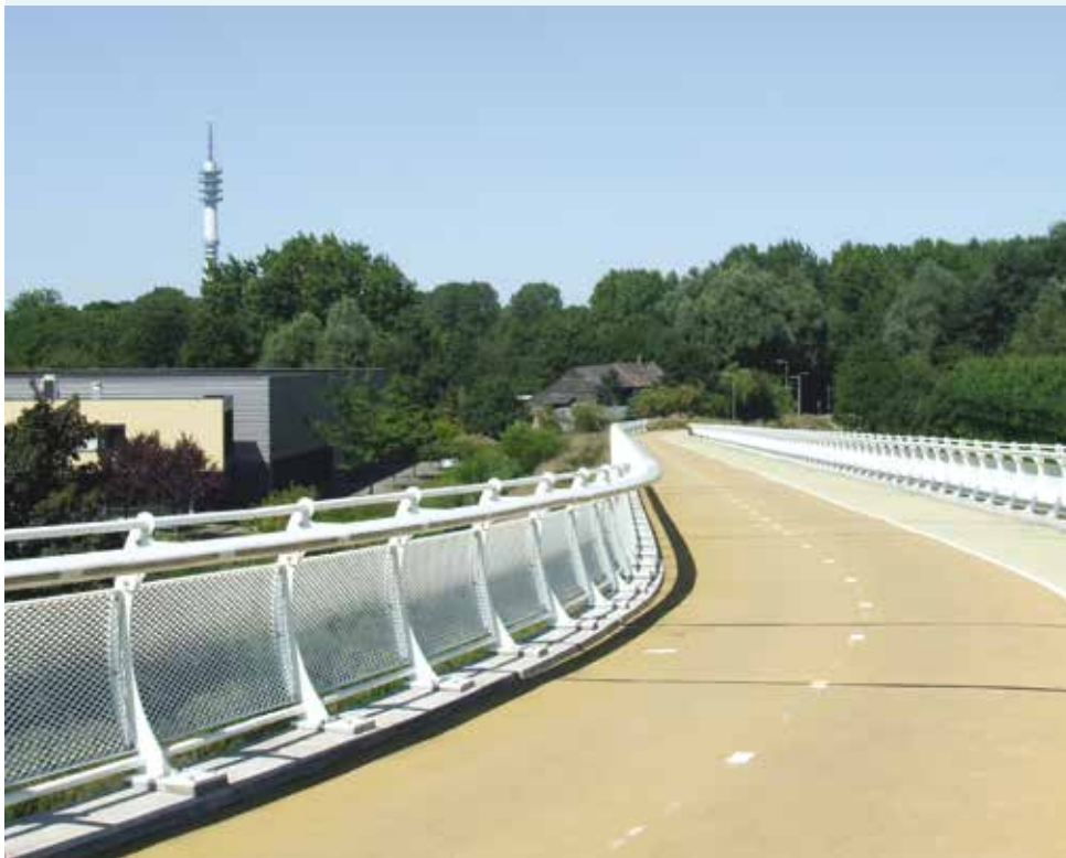
De noordelijke aanbrug (afrif) van de Groene Verbinding. (BRON: BART BEEN, DCMR)
