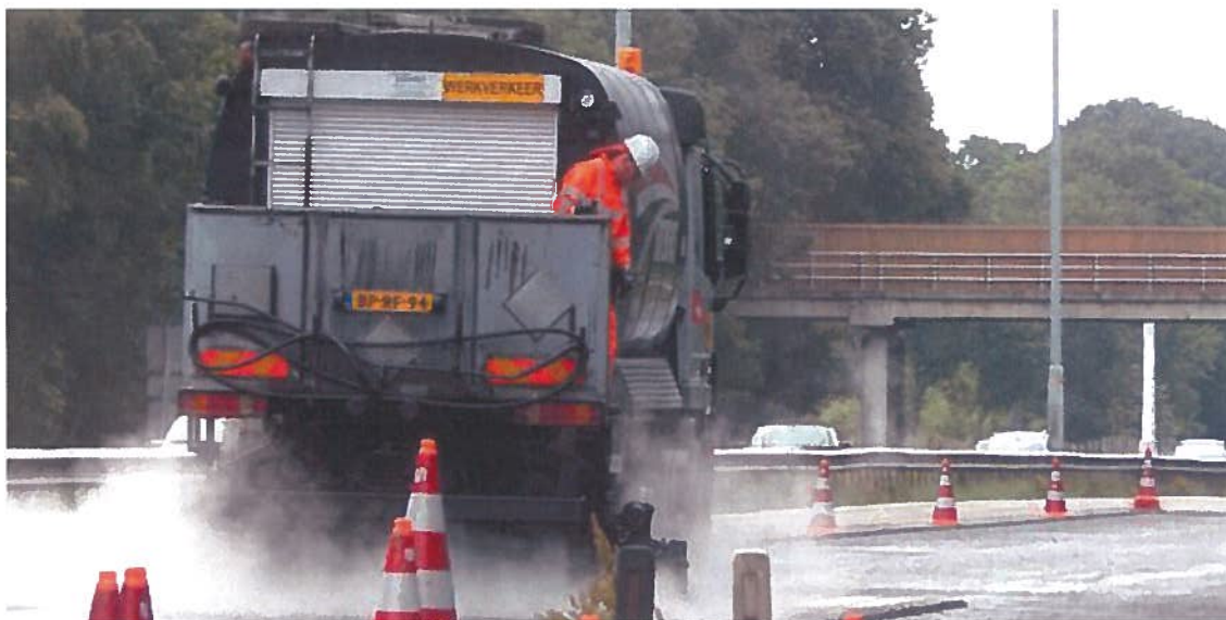
Figuur 9.1 Nieuwe asfaltoverlaging
