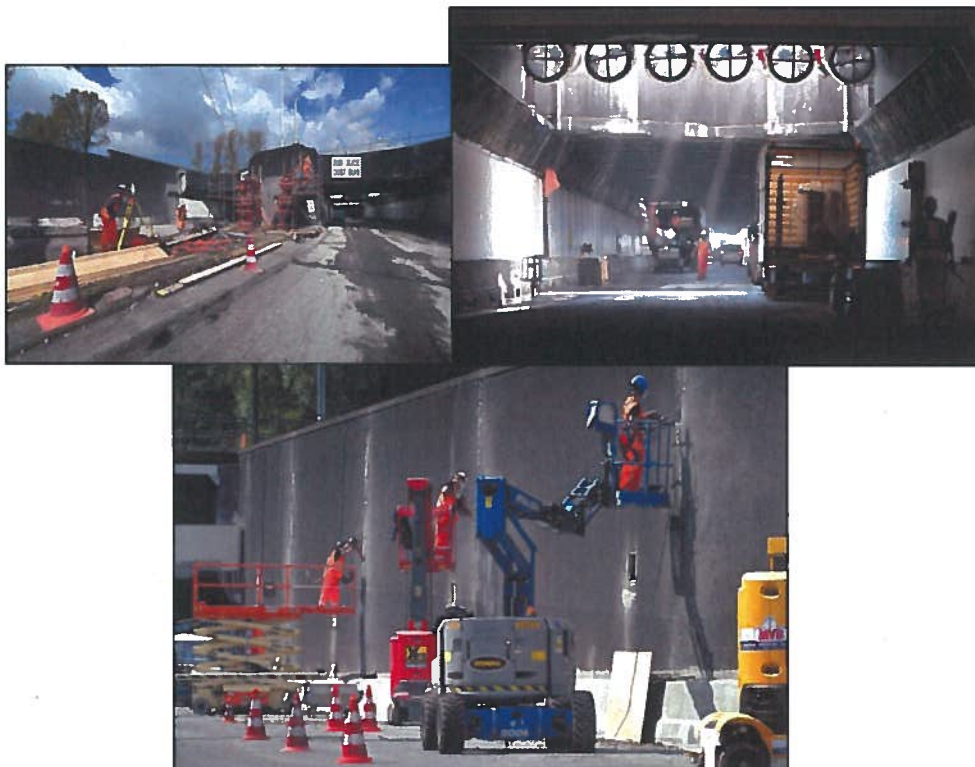
Figuur 8.3 Beelden van de renovatie van de Velsertunnel
