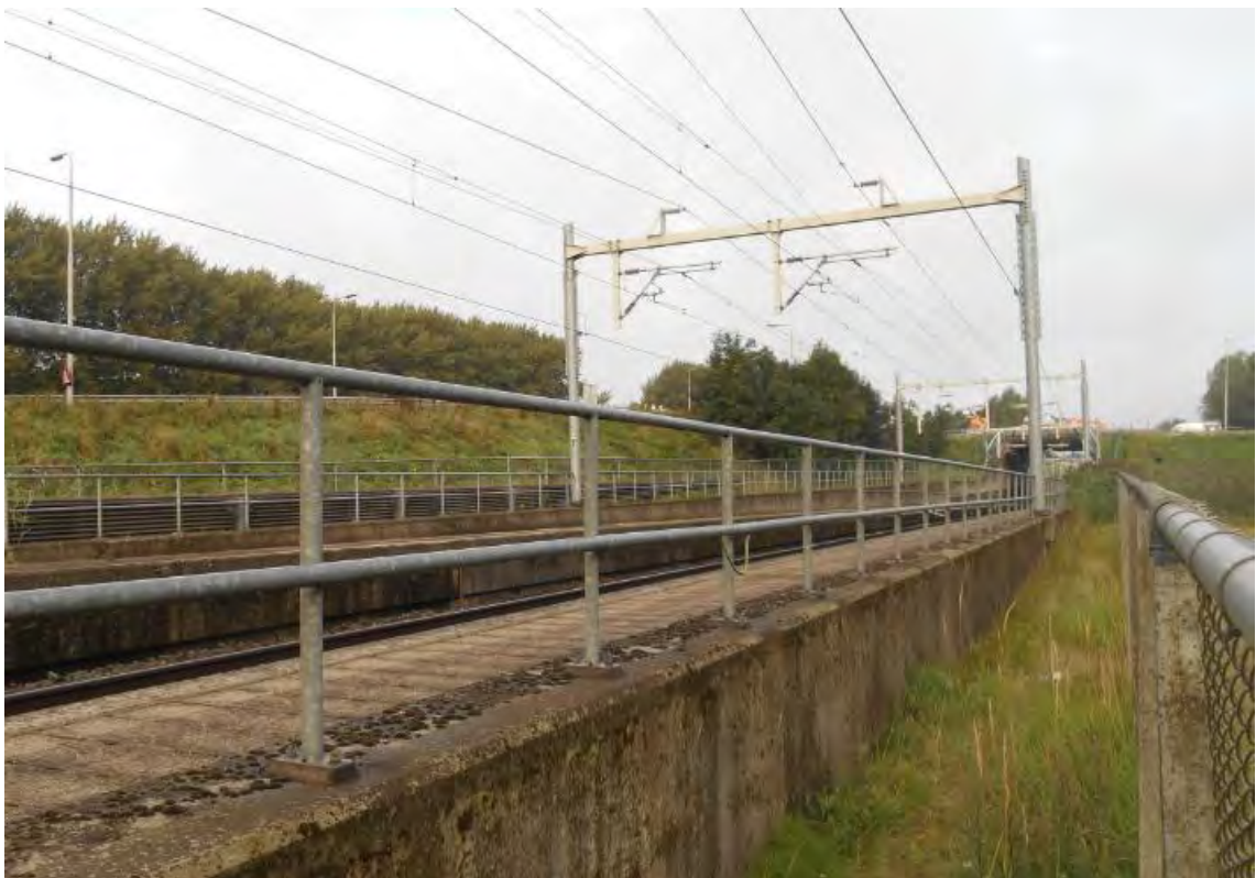
Afbeelding 5.2. Overzicht buitenwanden moot 03 (geringe mosgroei)
