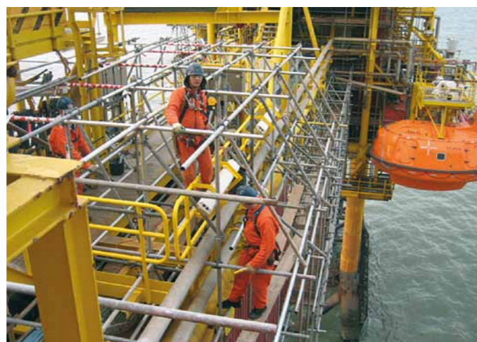
L7PK spiderdek hangsteiger in aanbouw (Foto: SodM)
