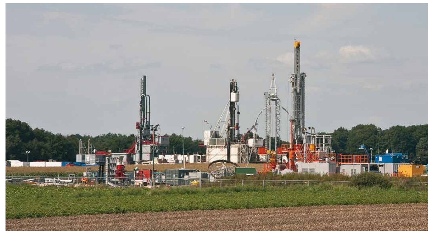
Drie installaties tegelijkertijd bezig met de aanleg van de boringen in Schoonebeek (Foto: R. Boomsema)
