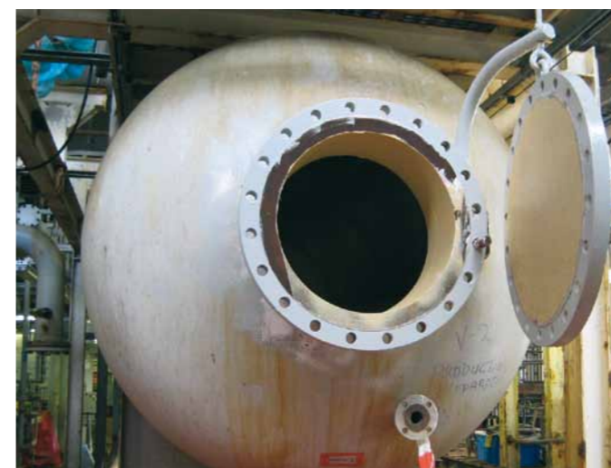
Productie separator gereed voor inspectie (Foto: SodM)
