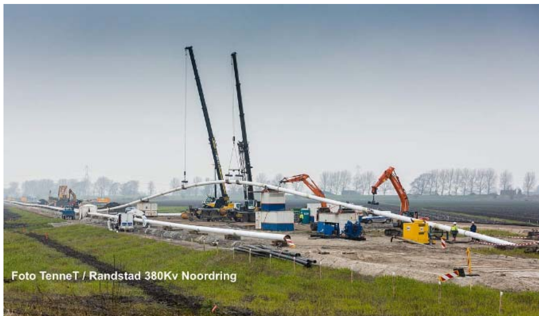
Figuur 5: Boring 2 circuits 380 kV
