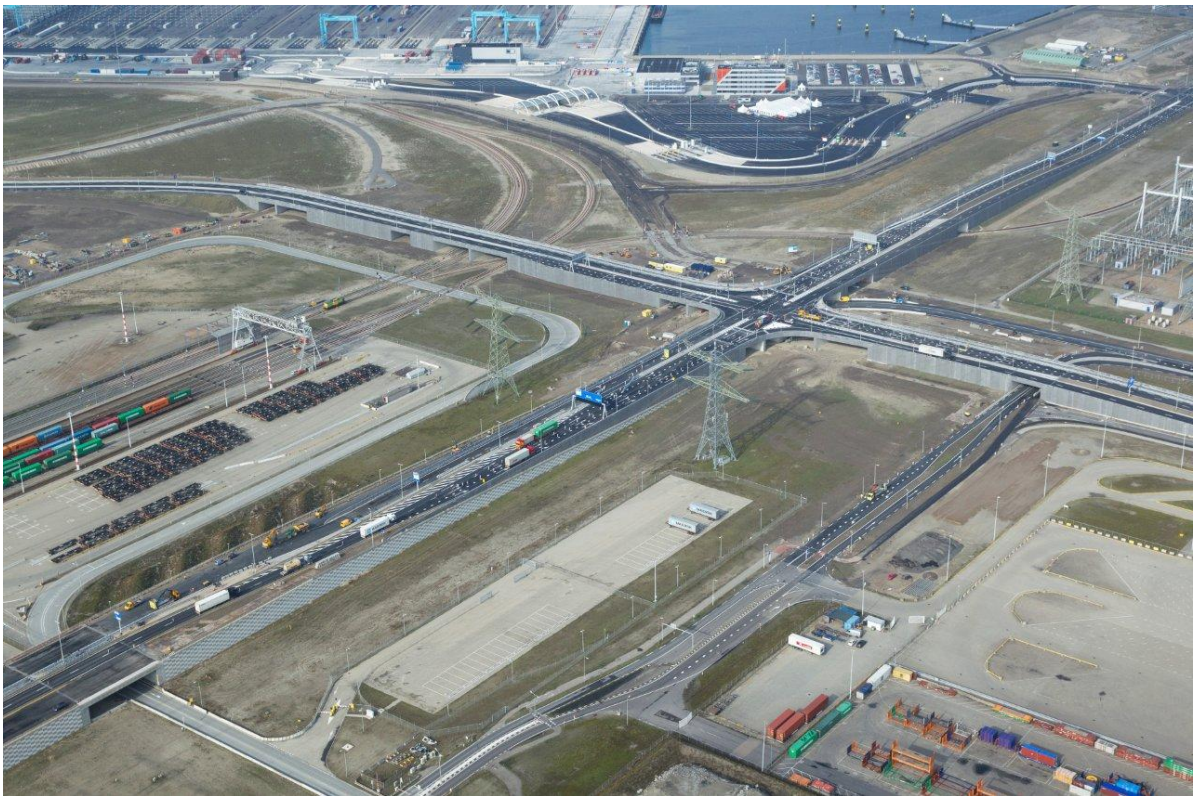
Figuur 2 Luchtfoto Coloradoviaduct, overgang Maasvlakte 1 – Maasvlakte 2 (opname: oktober 2014)
