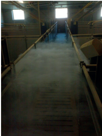
Controlegang met rookproef
