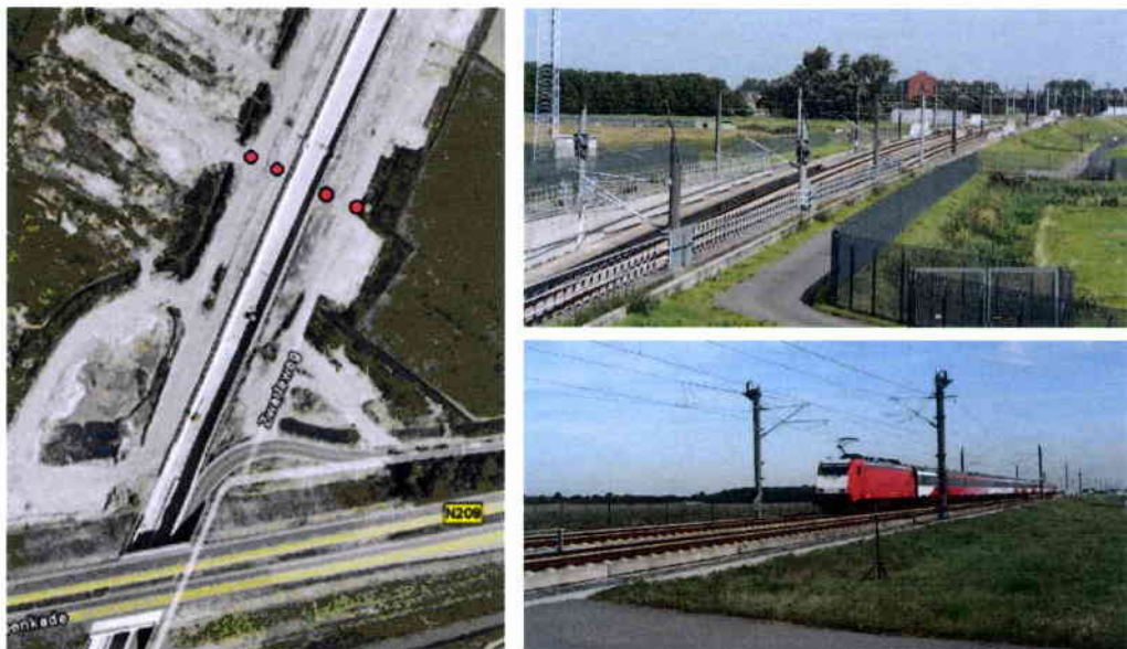
Figuur 2.1: De meetlocatie Schiebroek. De foto links is een luchtfoto in de situatie toen het spoor nog in aanbouw was. De rode punten in deze foto zijn de posities van de microfoons. De foto's rechts tonen het zicht richting noorden (Berkel en Rodenrijs/Amsterdam).
