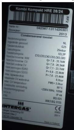
Figuur 26: Typeplaatje + bouwjaar CV-ketel woning 68
