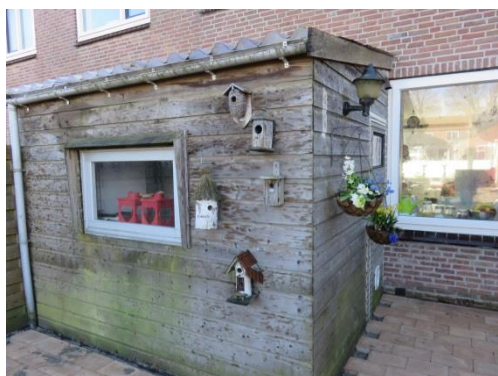
Figuur 18: Uitbouw woning 54
