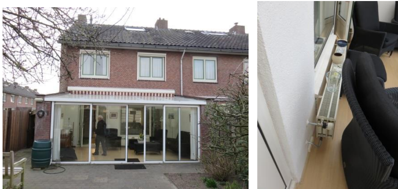
Figuur 42: Serre/uitbouw woning 127
