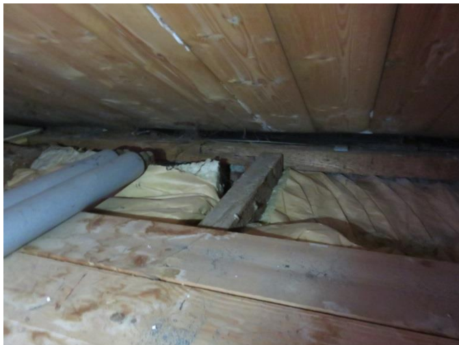
Figuur 17: Zoldervloer woning 43
