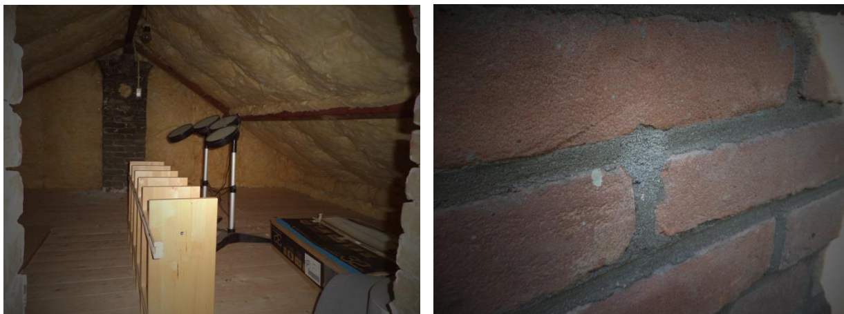
Figuur 40: dakisolatie en boorgaten in gevel woning 107
