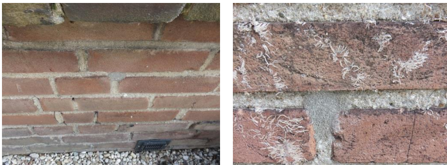
Figuur 66: Boorgaten woning 194
