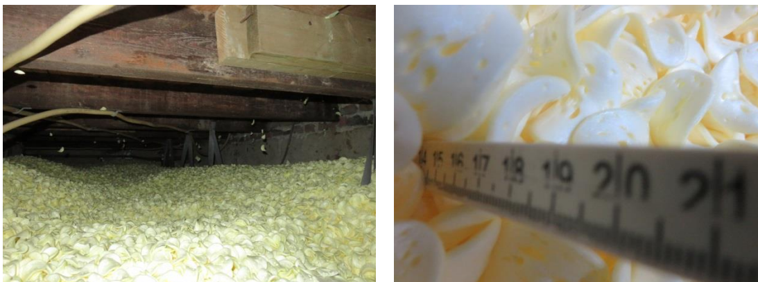
Figuur 67: Bodemisolatie woning 194
