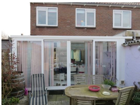
Figuur 38: uitbouw woning 100
