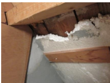
Figuur 3: Dakisolatie woning 1
