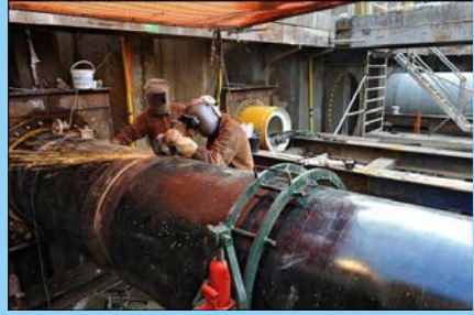
Diepe persing onder een kruising door van vier leidingen
