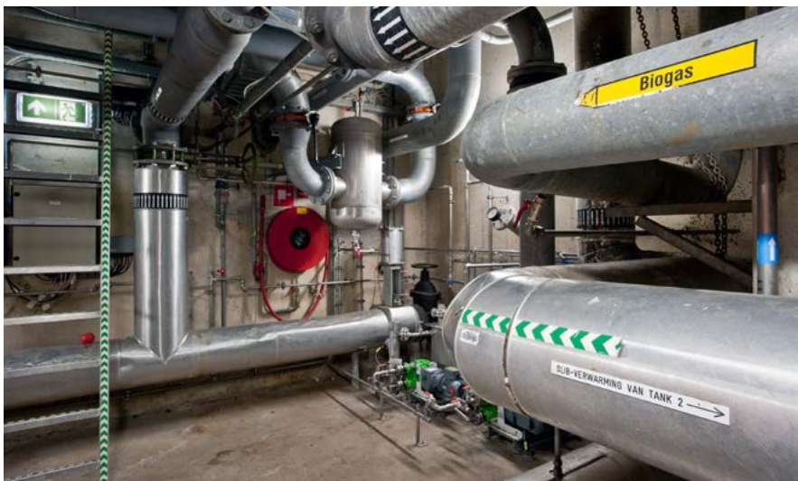
Installatie van de energiefabriek in Hengelo
