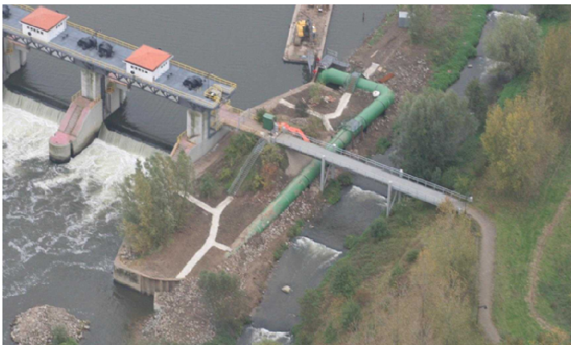
Figuur 7. De positionering van de hevelvistrap t.o.v. de bekkenvistrap en de stuw. Aan de onderzijde ligt de inzwembak in dezelfde kom waar ook de bekkenvistrap uitkomt.
