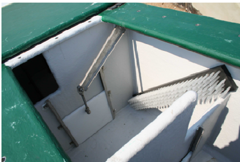
Figuur 5. De plaat met borstelharen in de hevelvistrap te Berghem ten behoeve van het vergemakkelijken van de passage van bodemvissen en –macrofauna.
