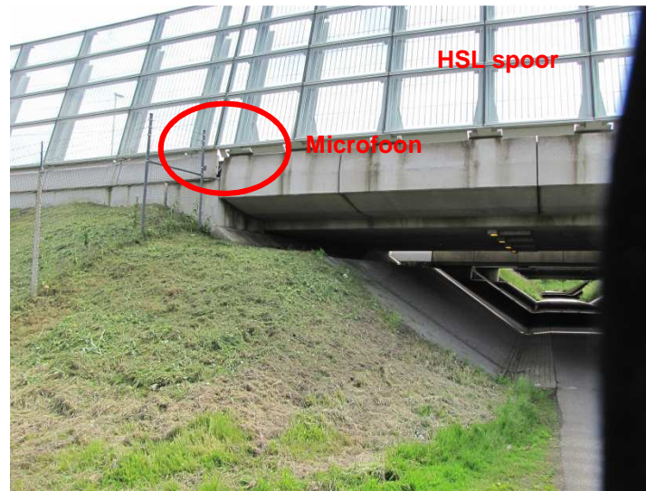
Figuur 10 Beeld van het geluidscherm en betonnen bak aan de westzijde van het HSL spoor waar de microfoon is neergelegd om de snelheid te meten.
