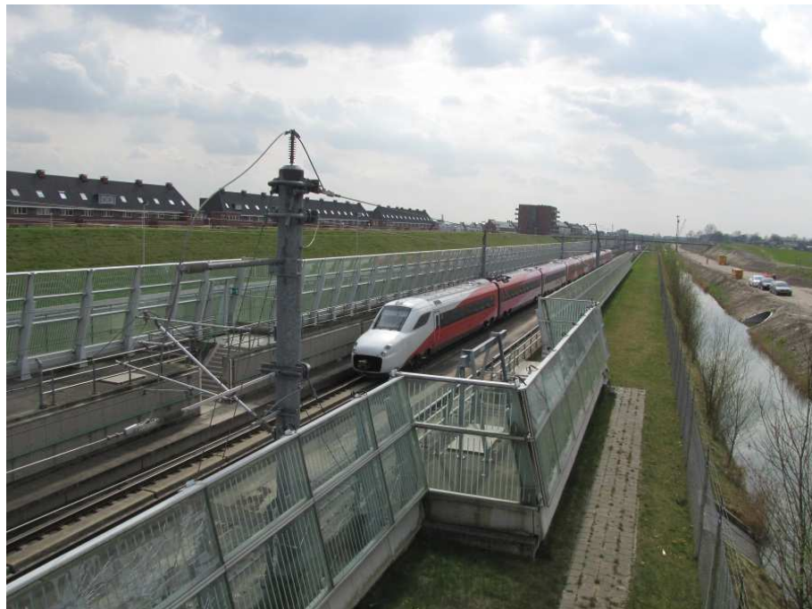
Figuur 1 Verdiept HSL-spoor in Lansingerland ter hoogte van het viaduct bij de Offenbachbaan, met een Ansaldo V250 trein rijdend in de richting Amsterdam. Het geluidscherm rechts strekt 2 bovenleiding portalen en houdt daarna op. Geheel rechts de Zoro-busbaan in aanleg.
