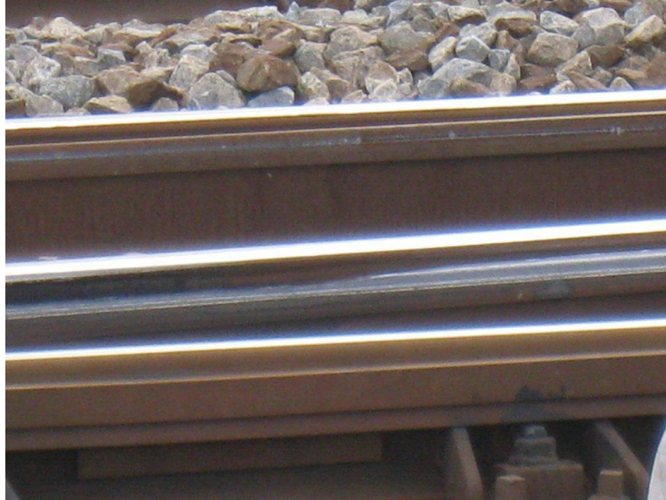
Figuur 2. Foto van de sterk versleten tong van wissel 223A/225b
