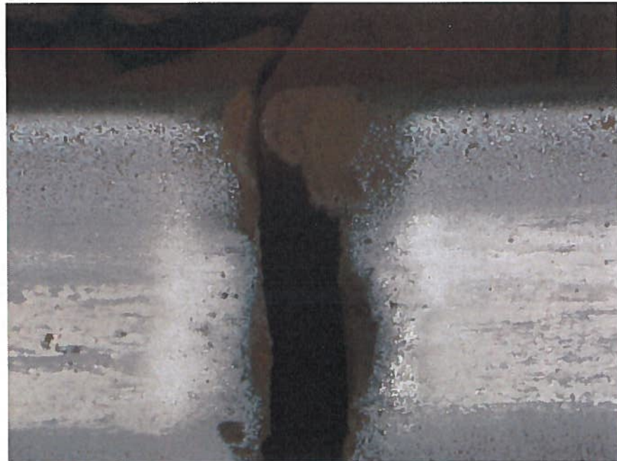
Figuur 11. Uitbrokkeling spoorstaaf in Zeeuvs Vlaanderen
