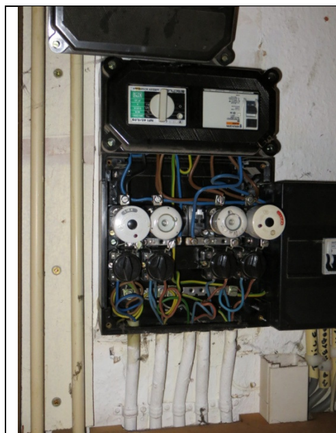
Figuur 16: open stoppenkast
