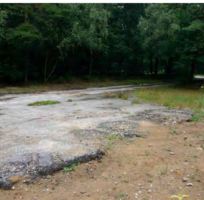
Locatie verwijderde bunker
