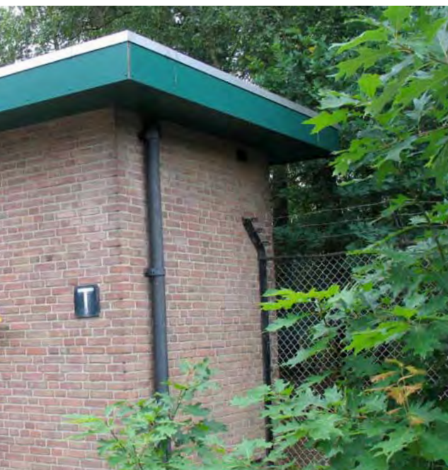
Plaats voor nieuwe toegangspoort in hek
