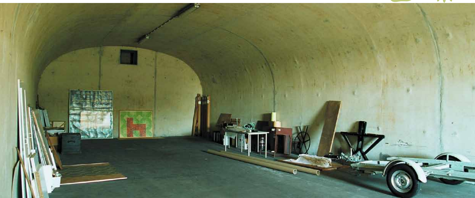
Bunker gebruikt voor opslag
