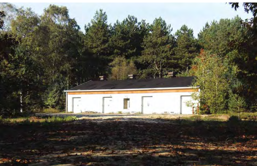
De overgebleven loods
