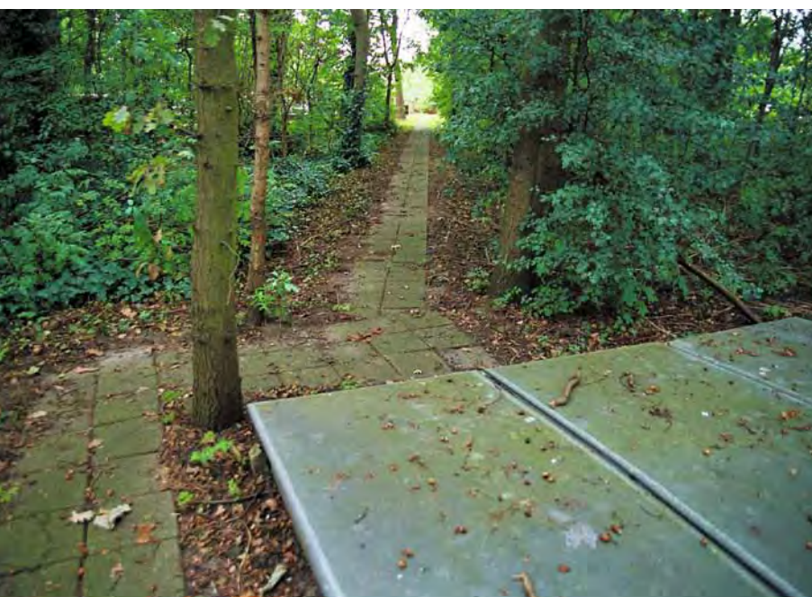
90 Dak van de bunker
