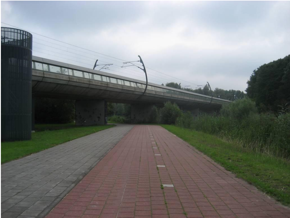
Figuur 3 Verlegde Havenspoorlijn door groengebied Drechterweide
