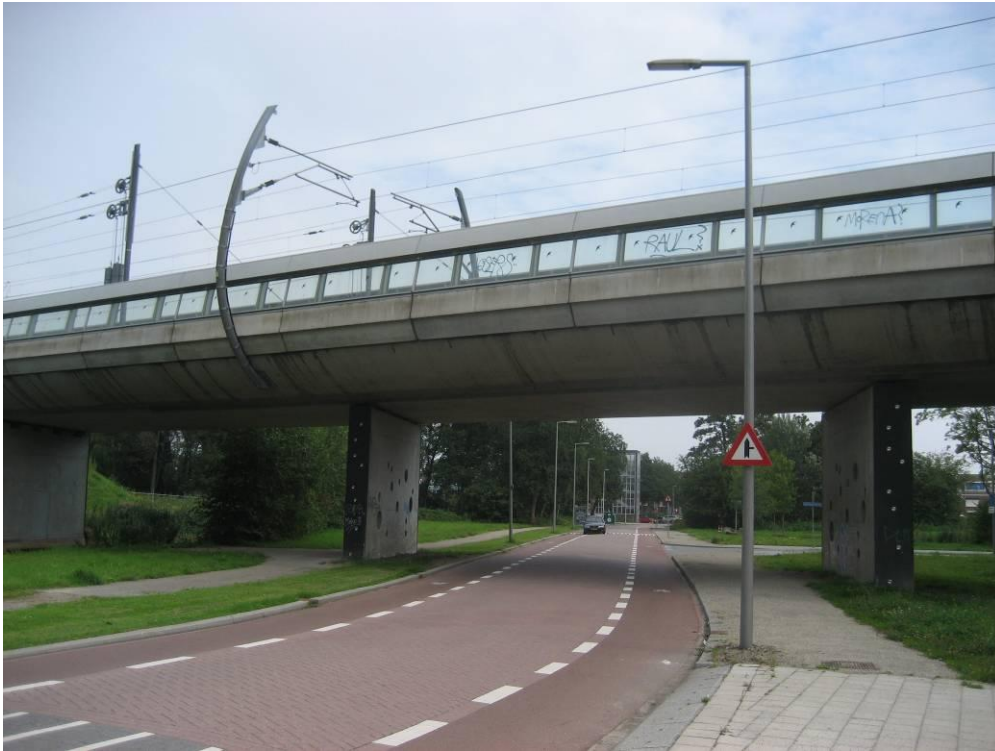
Figuur 2 Verlegde Havenspoorlijn over de Krabbendijkestraat
