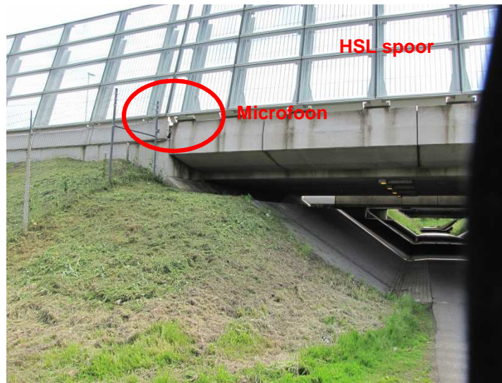
Figuur 10 Beeld van het geluidscherm en betonnen bak aan de westzijde van het HSL spoor waar de microfoon is neergelegd om de snelheid te meten.
