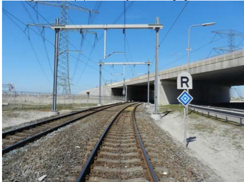
Afbeelding 4. Situatie op spoor 891 nabij de onderdoorgang N15.
