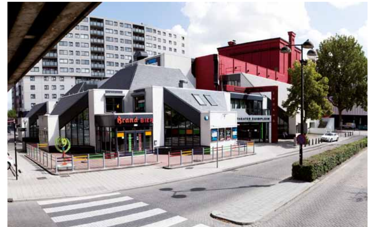
Entrance to Zuidplein Theatre / Entrée du théâtre Zuidplein
