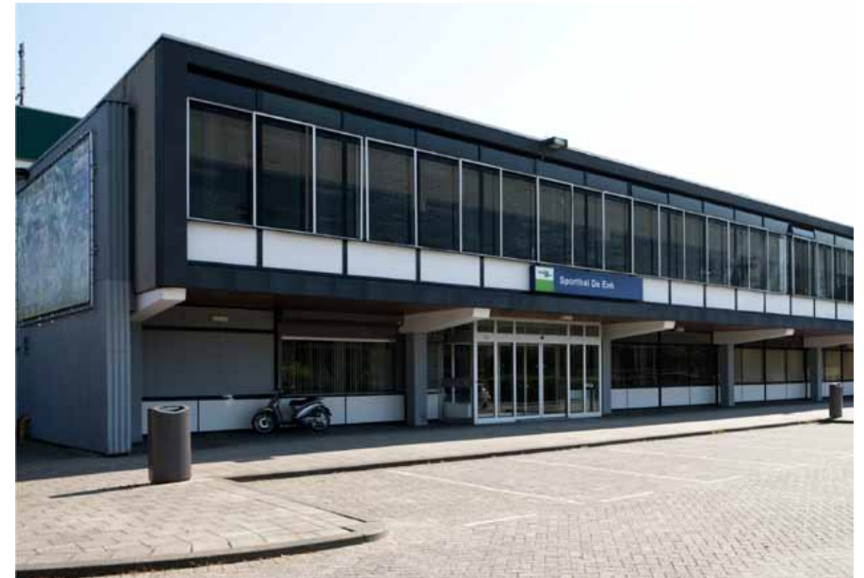
Entrance to De Enk Sports Hall / Entrée du complexe sportif De Enk
