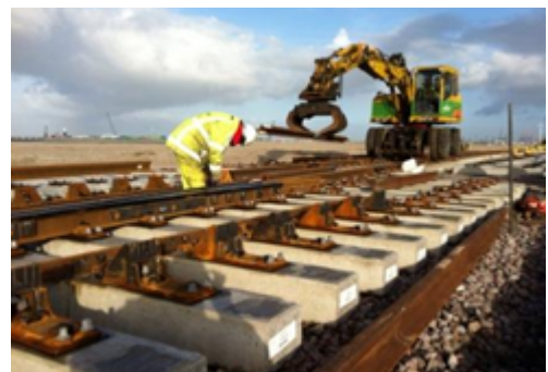
Foto: Spoorwerk in uitvoering (december 2011)
