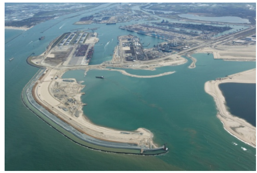
Foto: Luchtfoto Harde zeewering in aanleg (april 2012)
