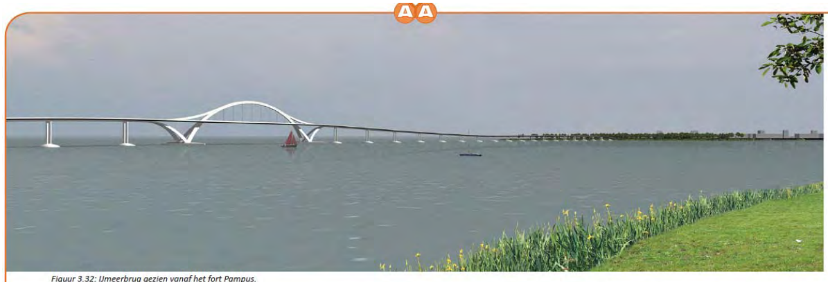
Figuur 3.32: IJmeerbrug gezien vanaf het fort Pampus.
