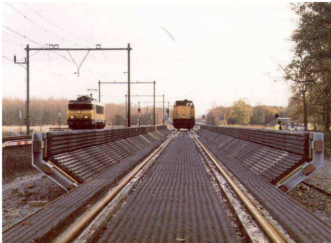
Figuur 5.14 Beproeving minischermen voorzien van geluidsabsorberend materiaal in het STV project.
