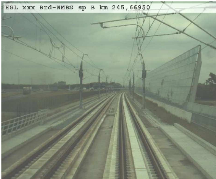
Figuur 3.1 Schermen die van het spoor af hellen bij Breda (referentie[6]).
