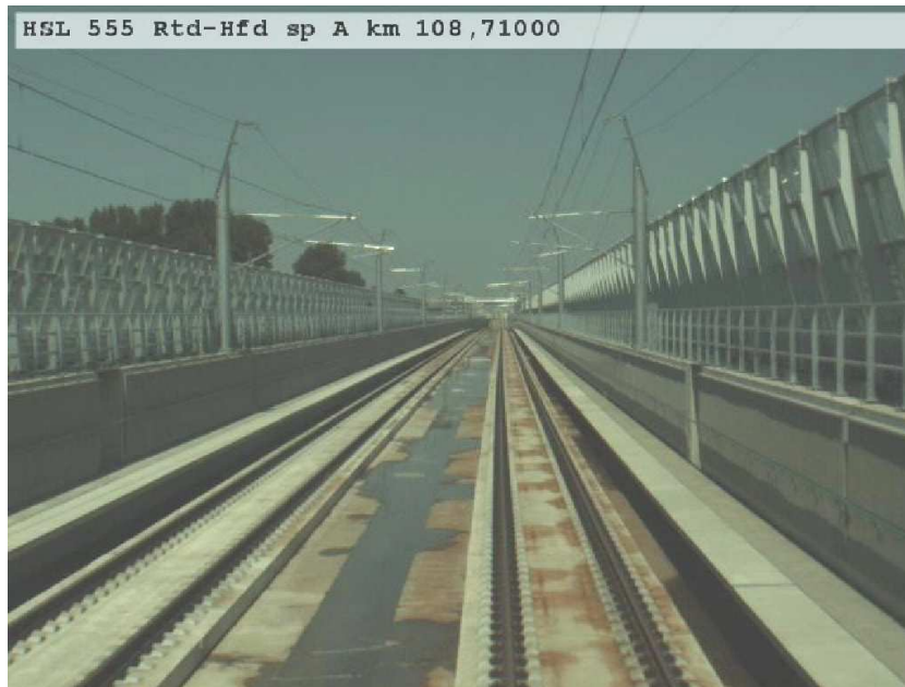
Figuur 6.7 Geluidsmaatregelen bij Berkel en Rodenrijs en bij Bergschenhoek; verdiepte ligging, absorptie platen en geluidsschermen.
