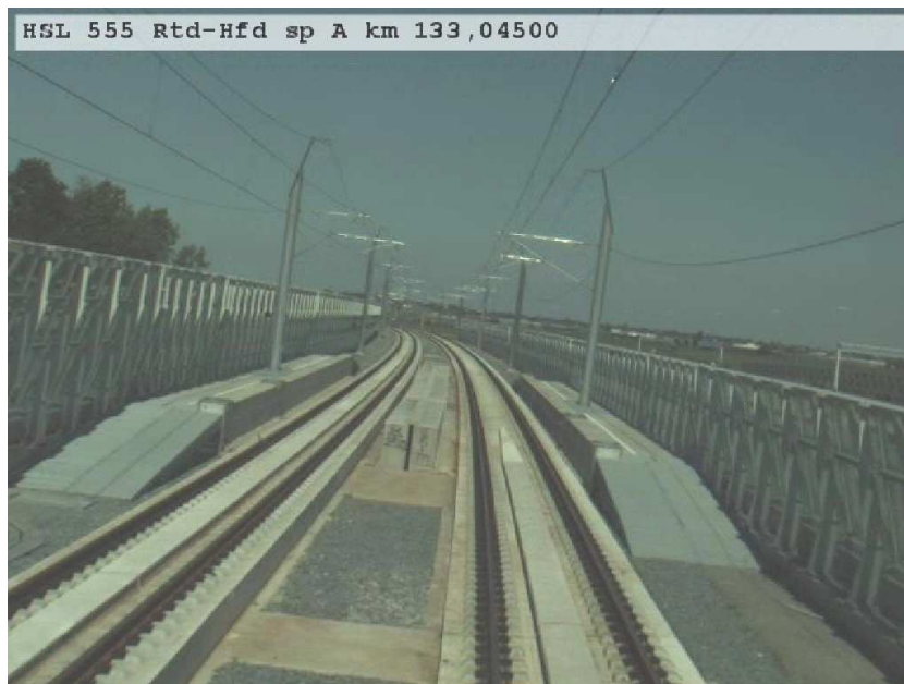
Figuur 6.5 Geluidsmaatregelen Rijpwetering (km 33,4) links hogere schermen dan rechts. Spoorbaan ligt 6 m boven het maaiveld (afkomstig uit referentie 7).
