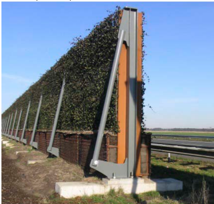
Figuur 26 Zij-aanzicht van het vegetatiescherm van Mostert de Winter (bron: IPL).
