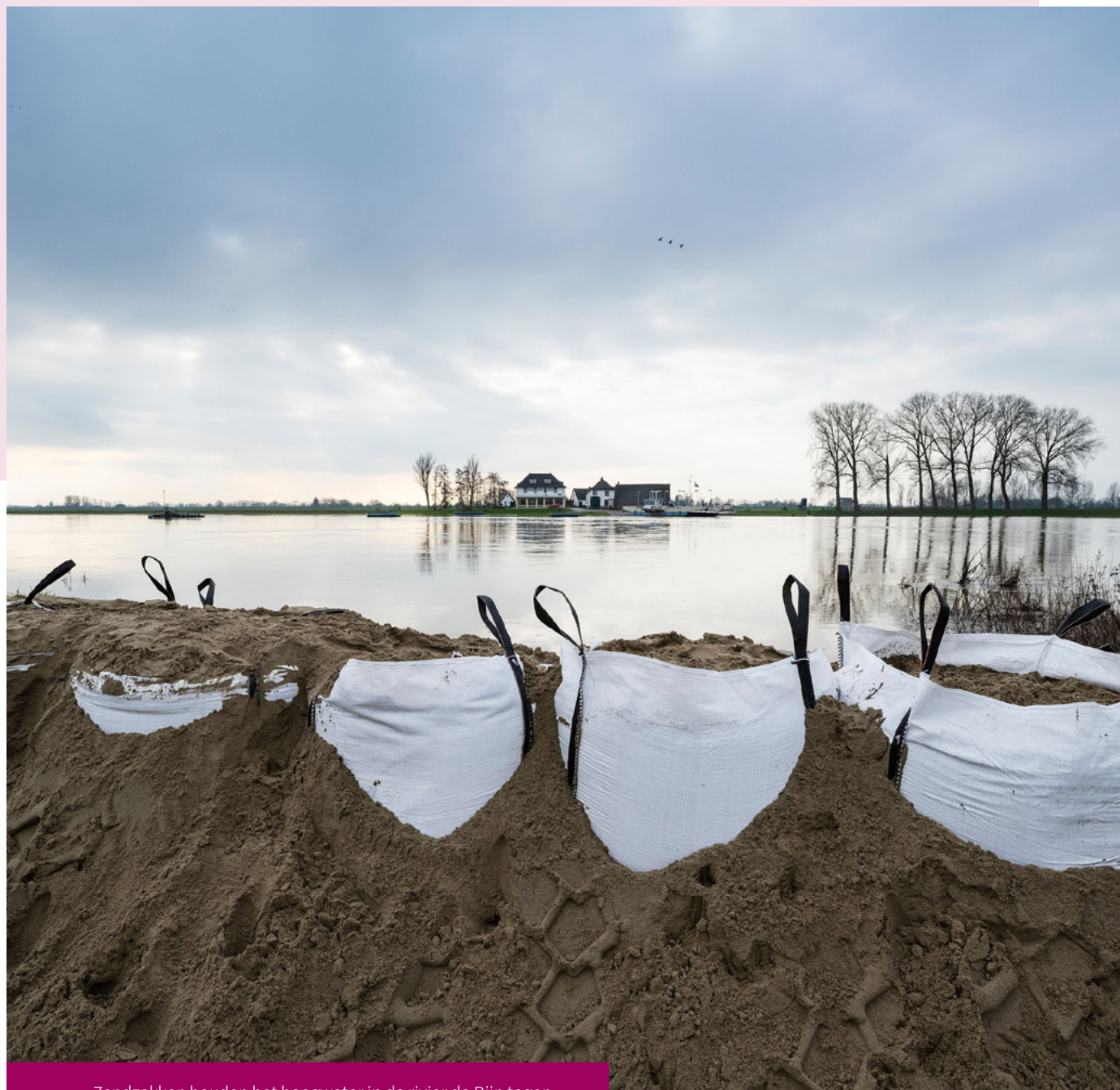
Zandzakken houden het hoogwater in de rivier de Rijn tegen.
