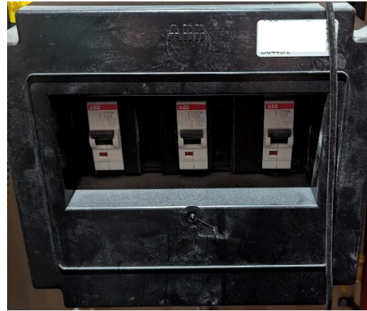
Figuur 3: Een hoofdzekering met verzegeling, met drie schakelaars. Beeld: Marten Witkamp
