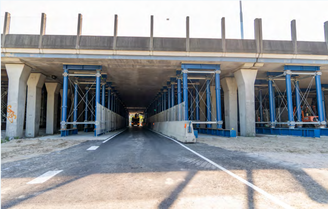
Opvangconstructie onder Kunstwerk 58, een viaduct in de A16.
