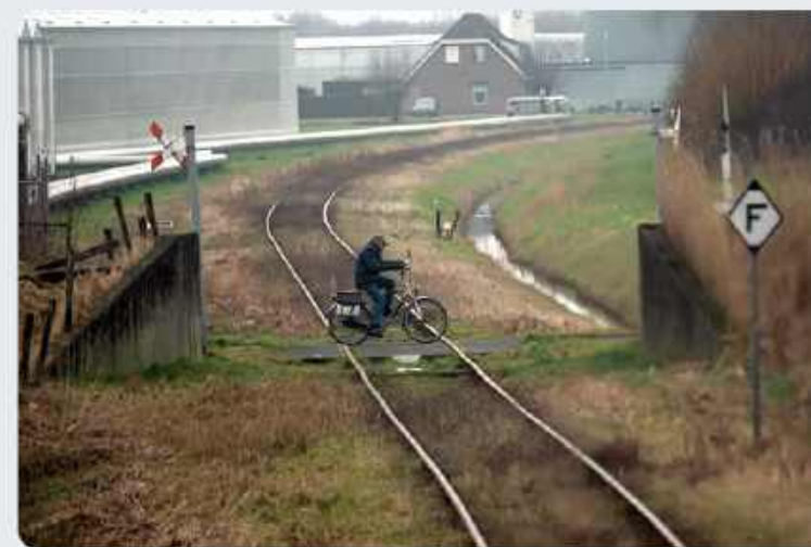
Figuur 19: Voorbeeld van één van de andere onbeveiligde overwegen op het baanvak Lag Zwaluwe – Oosterhout Weststad waar het zicht volledig belemmerd is door een betonnen wand aan beide zijden van de overweg (februari 2025) (bron: Onderzoeksraad voor Veiligheid).
